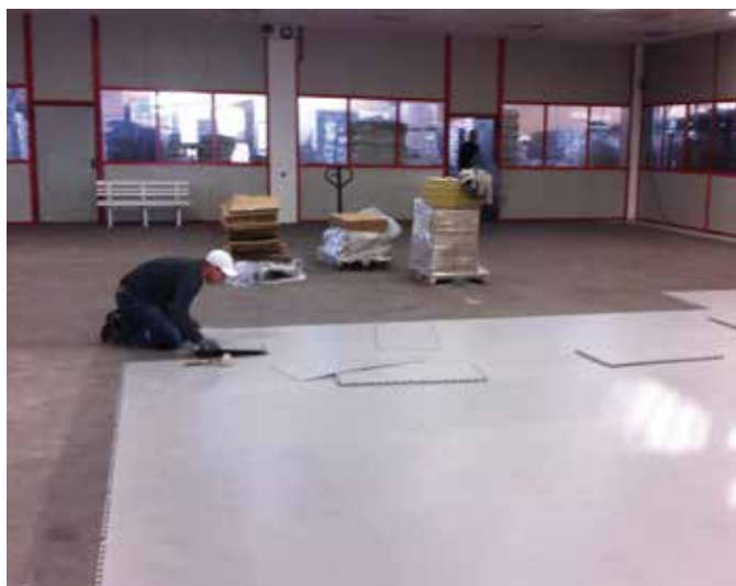
La fase di posa / Installation phase
